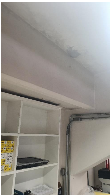
Figura 15 - Teto do Museu transpassado durante a instalação de barras antiesmagamento
