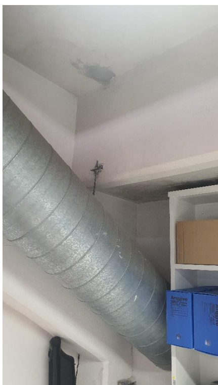
Figura 16 - Teto do Museu transpassado durante a instalação de barras antiesmagamento
