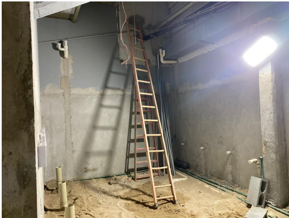
Figura 13 - Banheiros da arquibancada Norte
