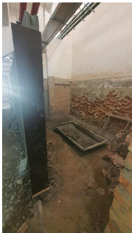
Figura 7 - Vestiários da Piscina
