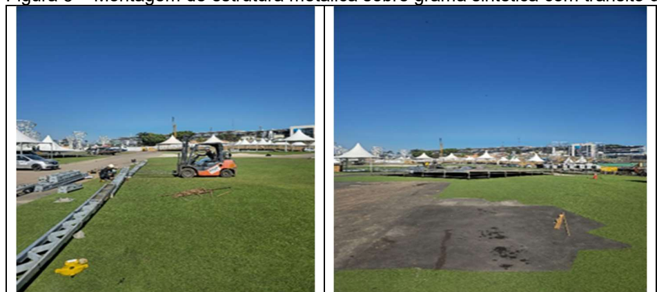
Figura 3 – Montagem de estrutura metálica sobre grama sintética com trânsito de empilhadeira
