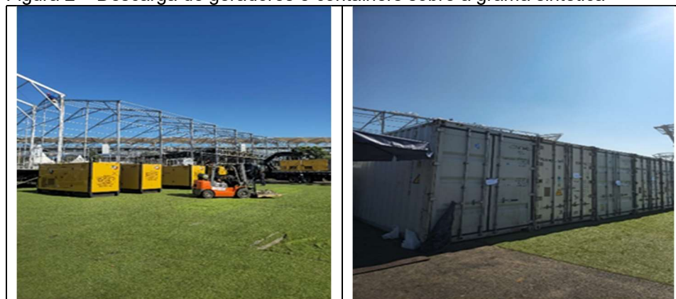
Figura 2 – Descarga de geradores e containers sobre a grama sintética
