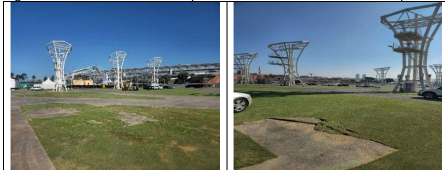
Figura 5 – Gramado danificado pelas manobras de caminhão e empilhadeira
