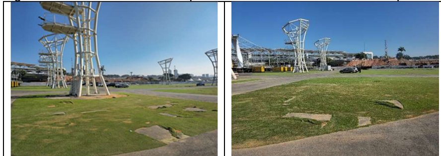
Figura 4 – Gramado danificado pelas manobras de caminhão e empilhadeira
