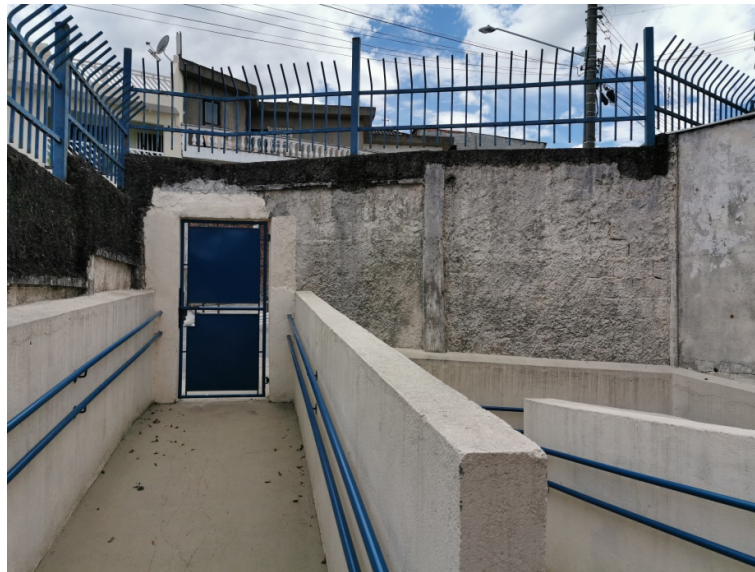
Foto 1 – Vista da rampa de acesso recém-construída.
