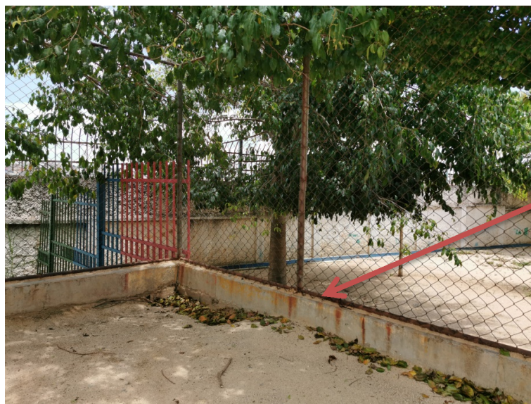
Foto 34 – Detalhe de gradil apresentando corrosão, em desacordo com o memorial descritivo que previa a sua substituição.
