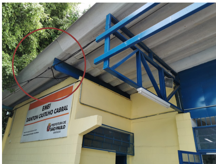
Foto 12 – Outra vista da estrutura metálica com condutores elétricos aparentes.
