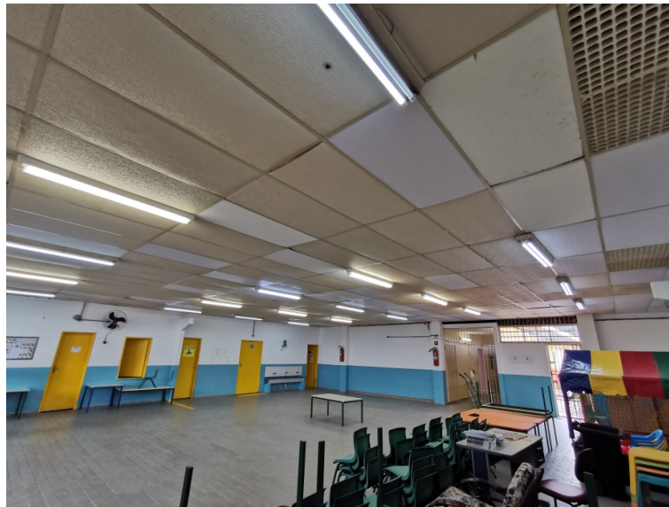
Foto 13 – Detalhe da iluminação. Observou-se, na vistoria realizada, que foram acrescentadas 02 fileiras de luminárias.
