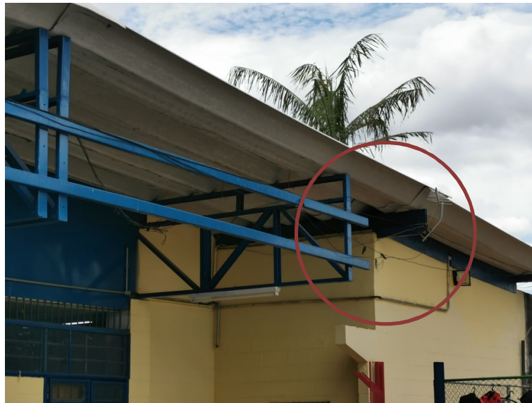
Foto 11 – Outra vista da estrutura metálica com condutores elétricos aparentes.
