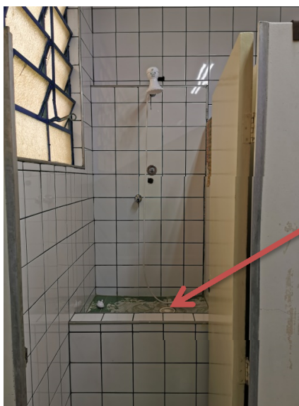
Foto 26 – Vista da ducha das crianças apresentando problemas quanto à segurança, piso elevado com risco de resvalo sem proteção ou barras de apoio.
