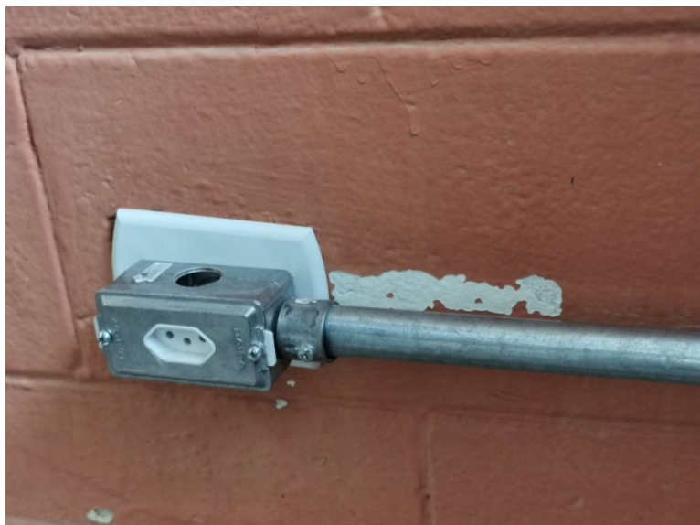
Foto 18 – Detalhes de elementos da instalação elétrica após reforma, em desacordo com o memorial descritivo.
