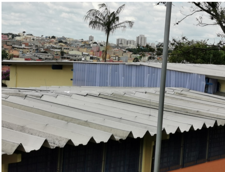
Foto 25 – Vista do telhado apresentando telhas substituídas e SPDA.
