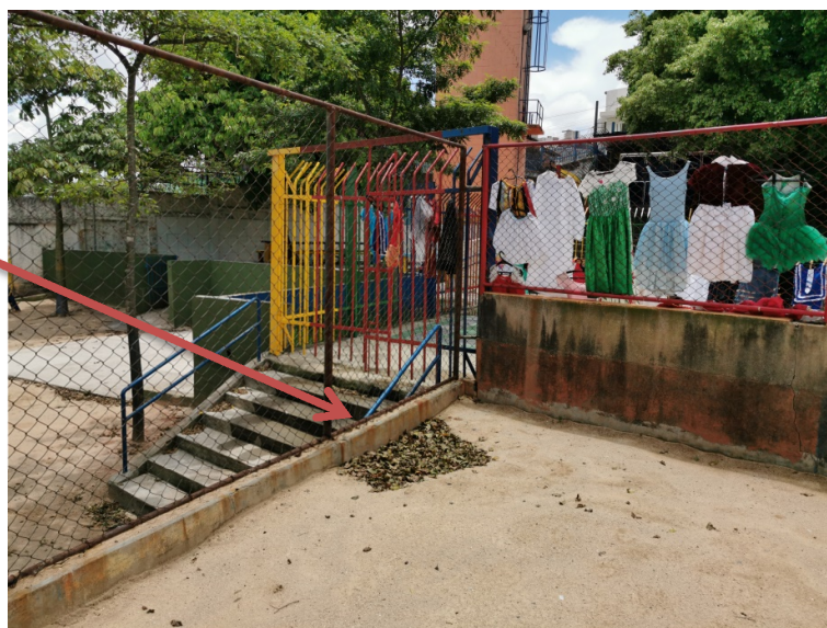
Foto 35 – Outra vista do gradil apresentando corrosão.
