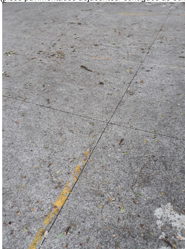
Figuras 7 e 8- Acúmulo de sujeira na parte externa (pisos pavimentados adjacentes/ contíguos às edificações)
